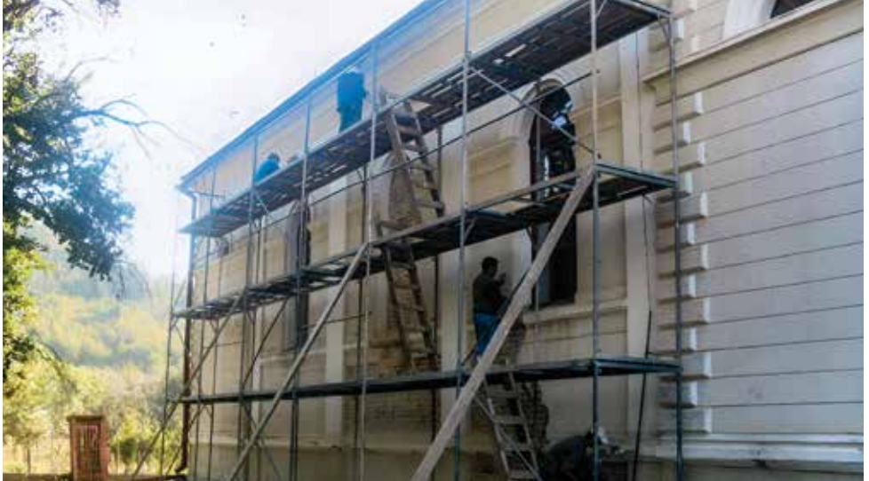
Sanierung der Kirche in Almas, 2010
